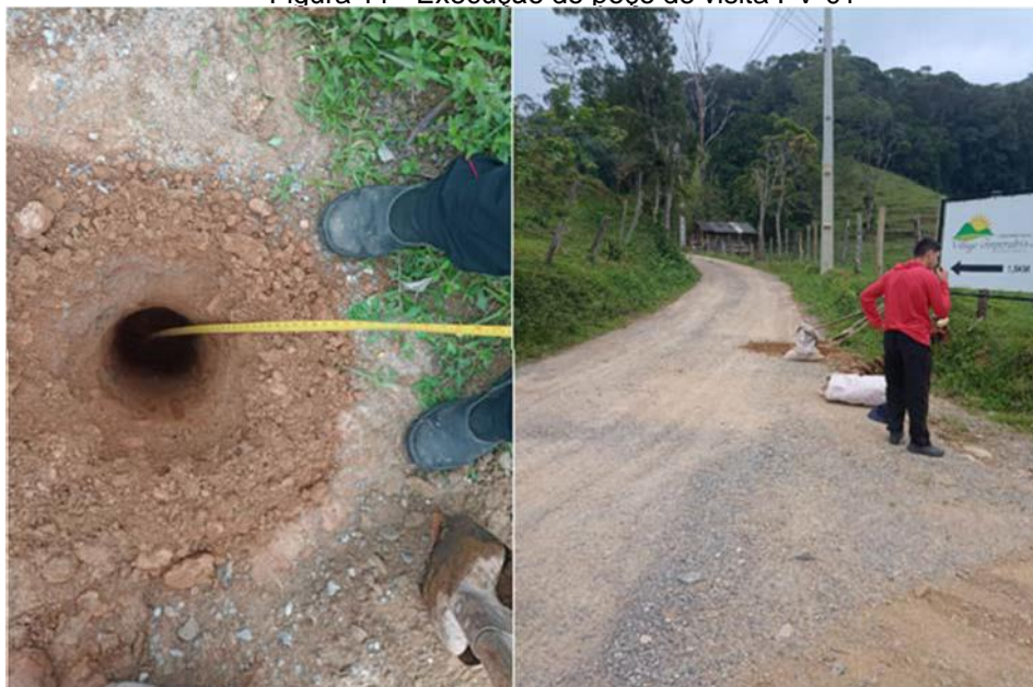
Figura 11 - Execução do poço de visita PV-01
