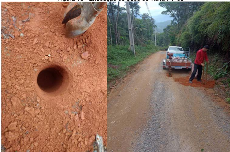
Figura 15 - Execução do poço de visita PV-05
