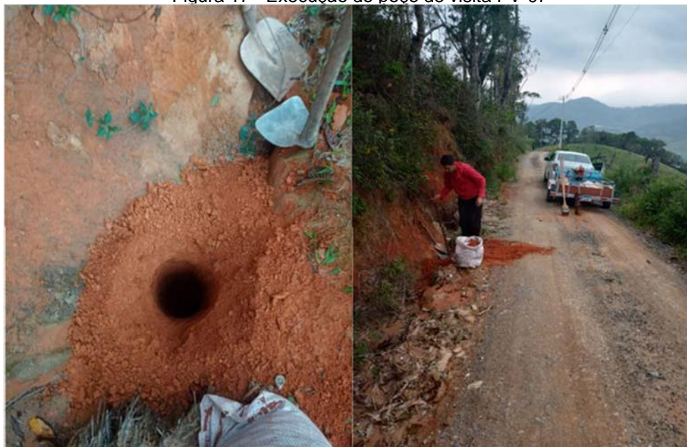
Figura 17 - Execução do poço de visita PV-07
